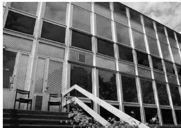
Az eredeti alumínium-üveg függönyfal
