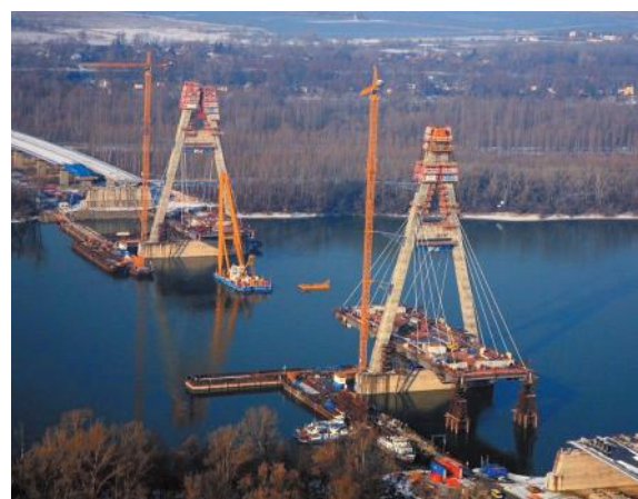
Felszerkezetszerelés
