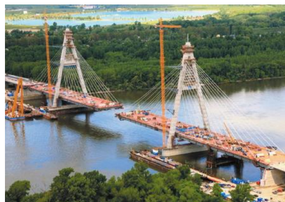
Felszerkezetszerelés
